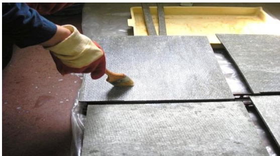
Рис. 3. Технологічний процес радіаційно-хімічної модифікації: механічне нанесення олігомеру на поверхню зразків шиферу (зліва); зразки на конвеєрі транспортної лінії (справа).
